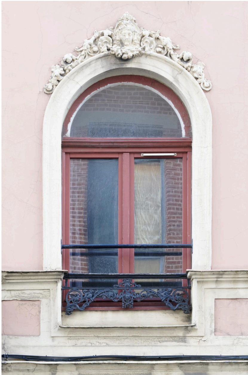
Décors floraux sur les encadrements de fenêtre du premier étage.
