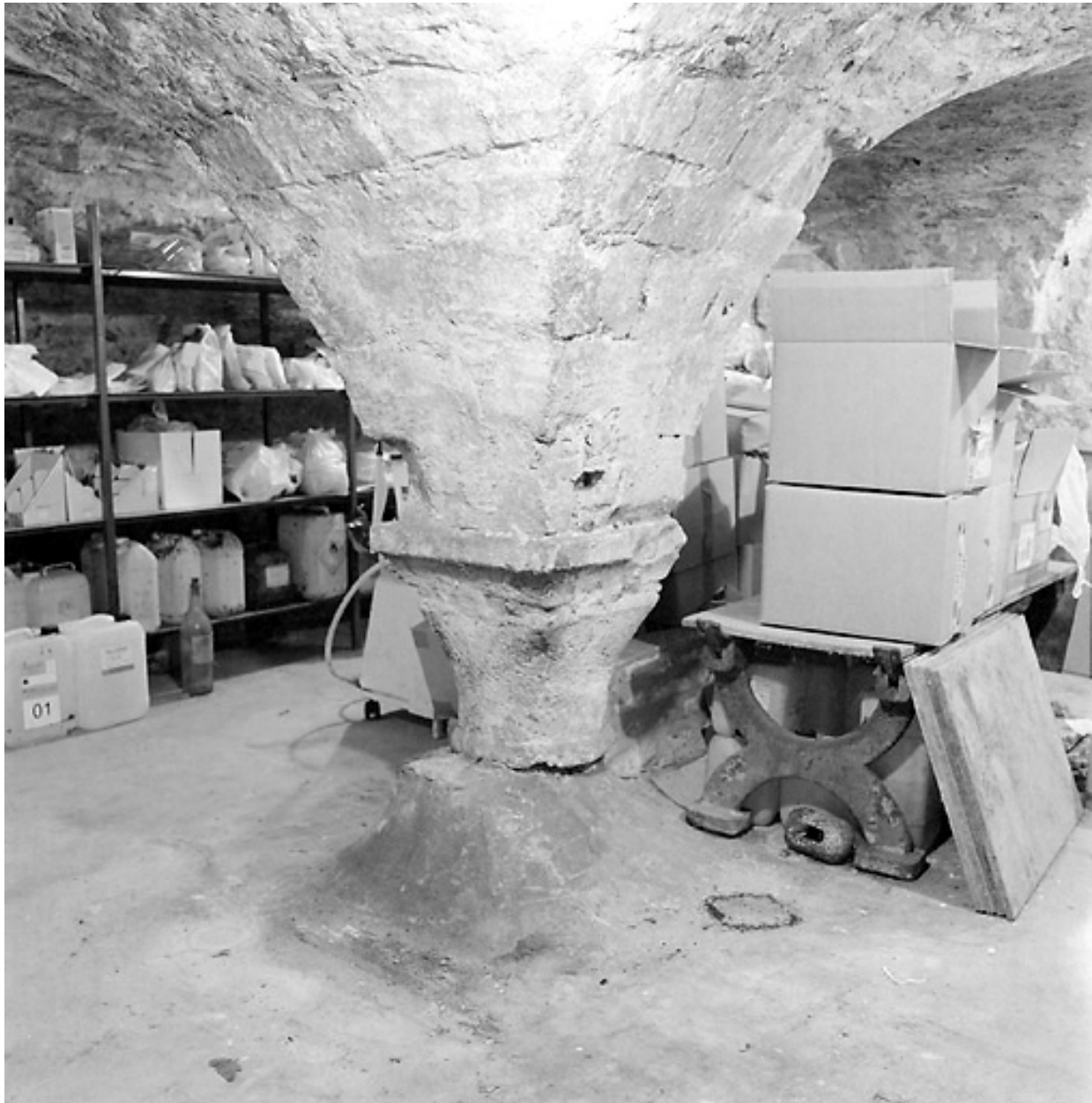
Sous-sol, vue partielle : cave médiévale, colonne arrière et son chapiteau.
