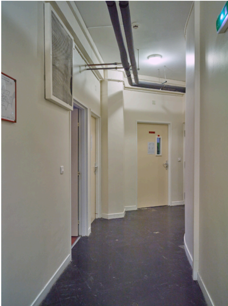
Vue du poteau de forme hexagonale, situé dans le couloir circulaire desservant les chambres de la tour de l'internat.
