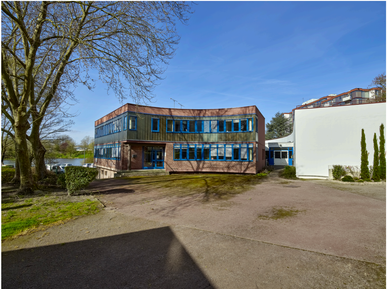
Bâtiment L à usage de bureaux, entrée de l'ancienne école maternelle, garages.
