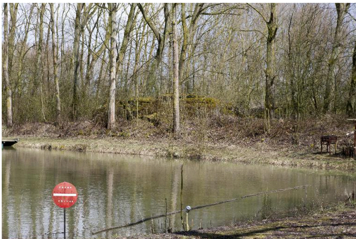
Aubers, casemate de commandement 303 sous la végétation.
