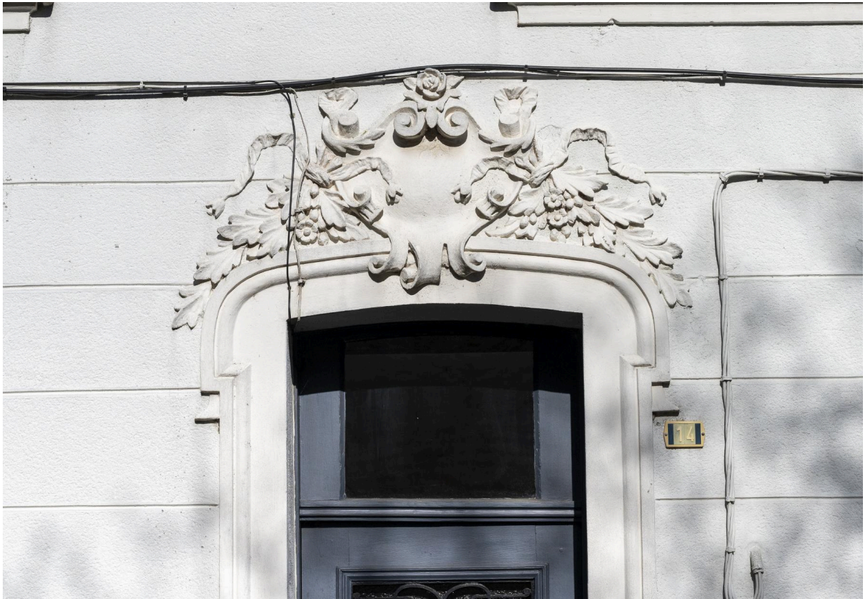
Maison de maître avec façade décorée et porte soulignée - 14, rue de l'Aulette : détail du décor plaqué au-dessus de la porte.
