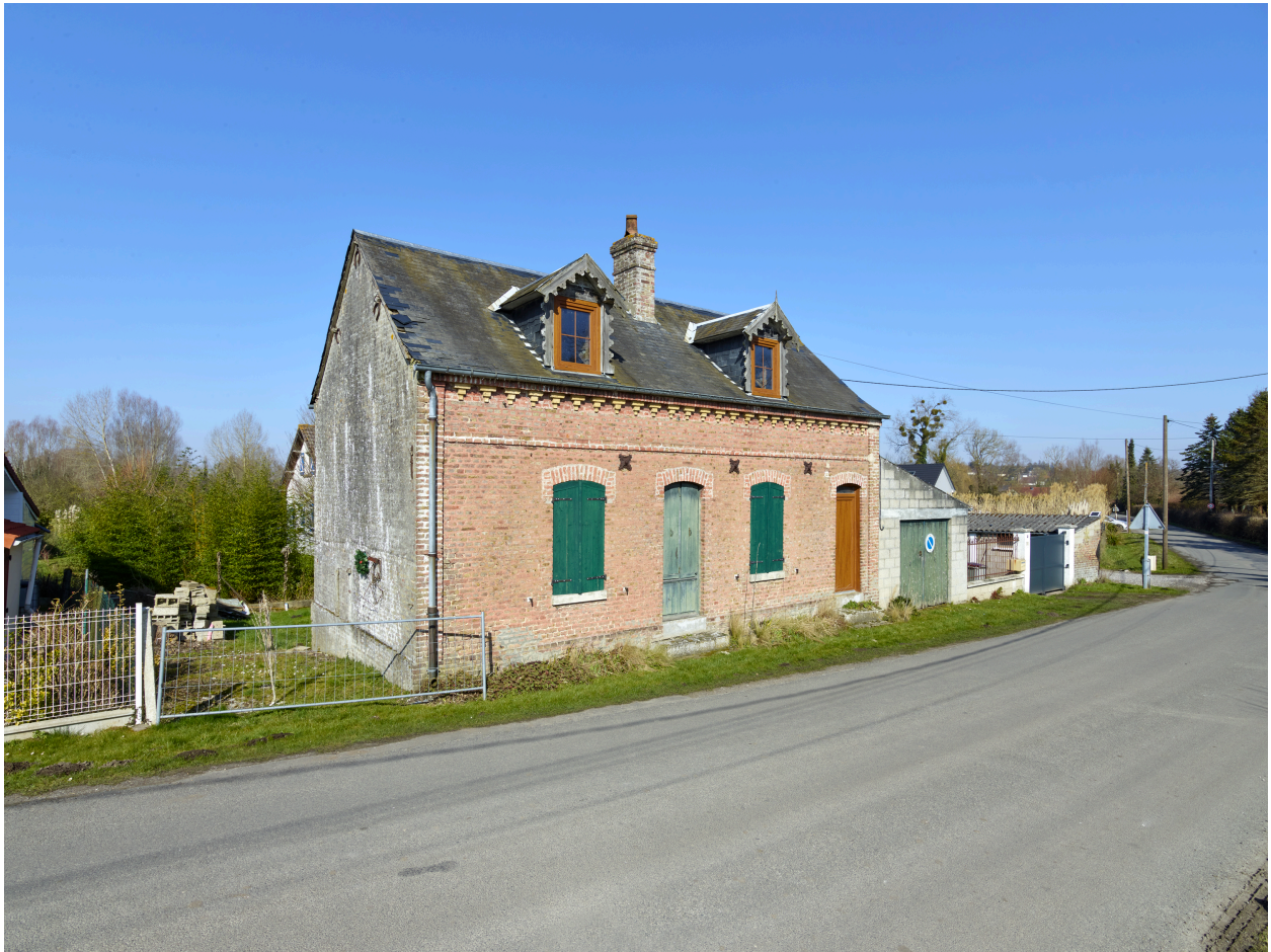
Maison, 3 rue de la Gare à Petit-Laviers.
