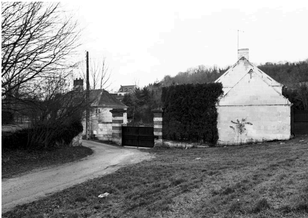
Vue générale de l'entrée de l'usine, avec la conciergerie et le bureau.
