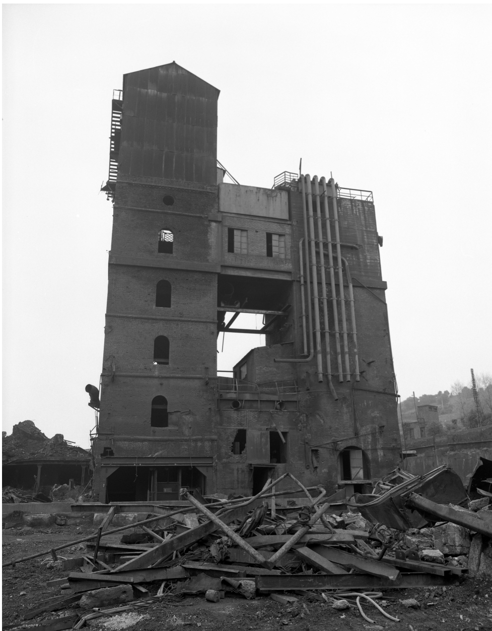
Elévateur, façade nord.
