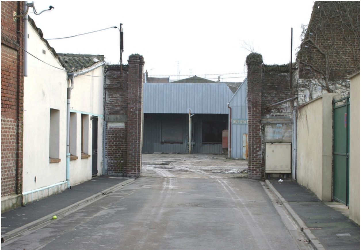
Entrée du site, rue Joséphine.
