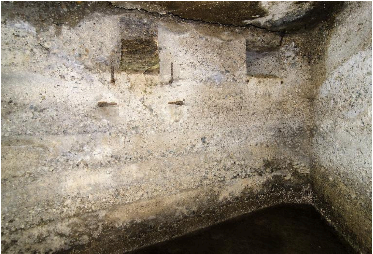
Vue intérieure. Partie droite de l'abri.
