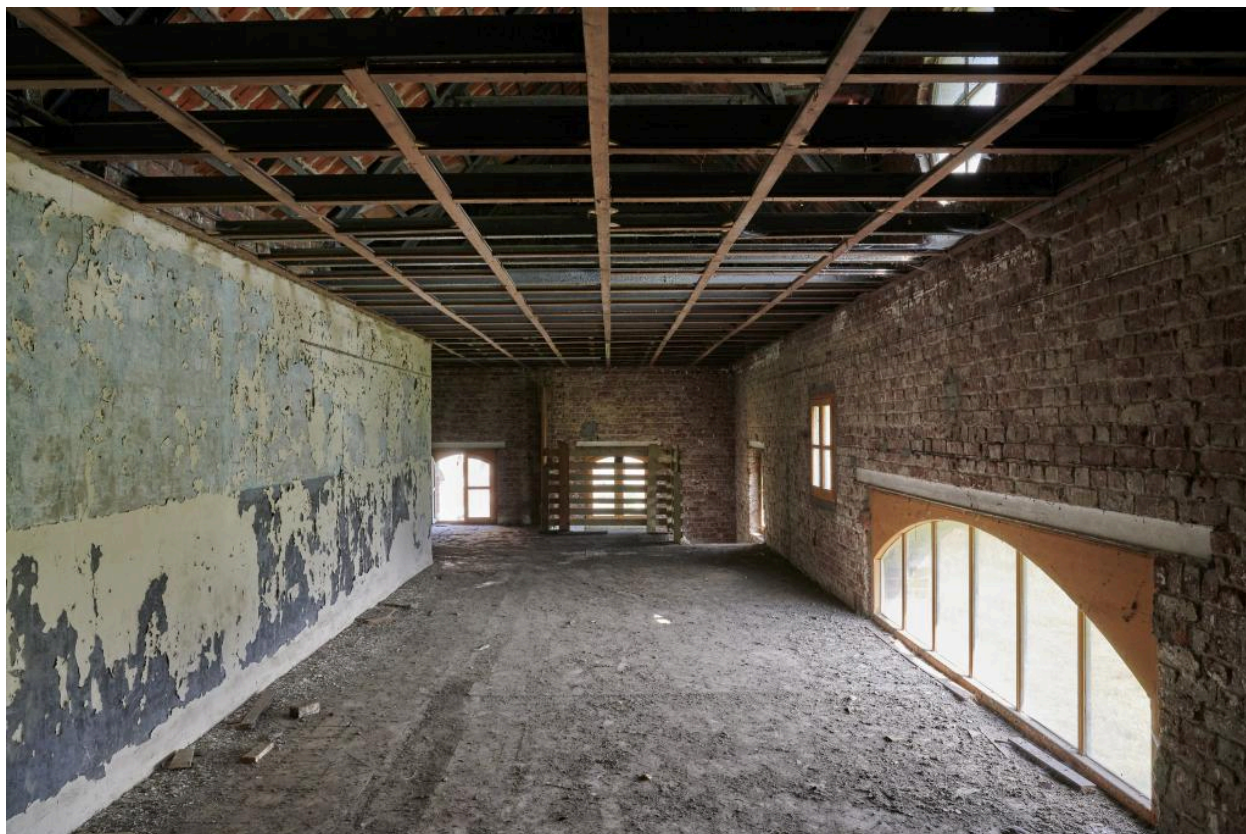
Combles des anciens magasins.
