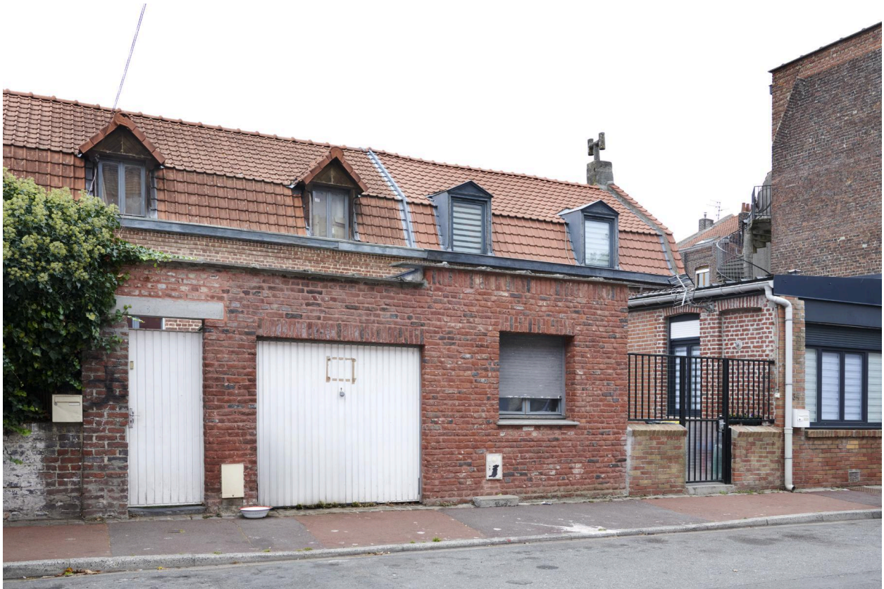
Vue générale de la rue.
