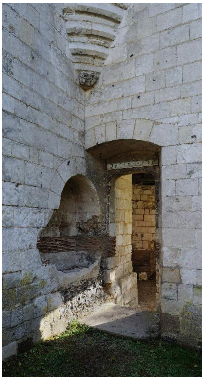
Détails intérieurs de la porterie : baie, lavabo en niche et échauguette.
