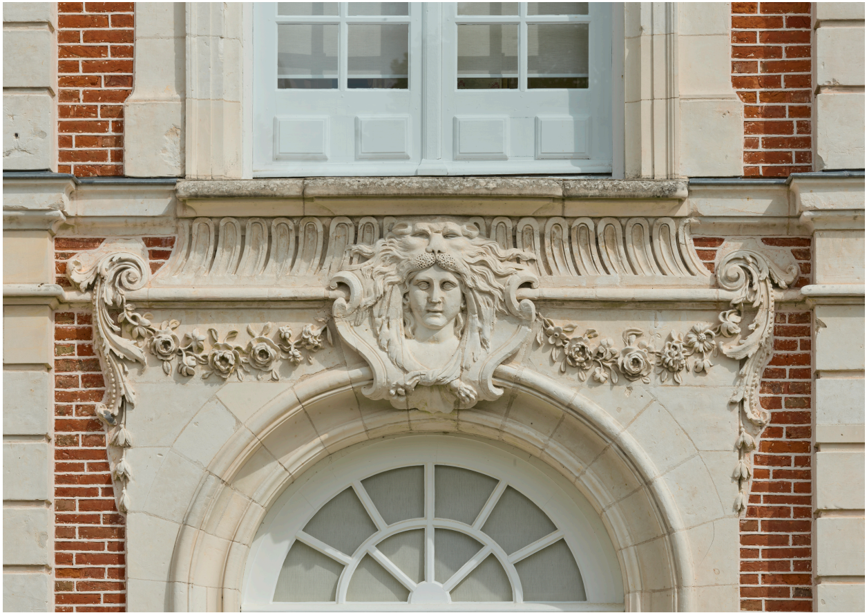
Avant-corps central, façade sur cour, détail de l'agrafe sculptée en couronnement de la baie centrale au rez-de-chaussée.
