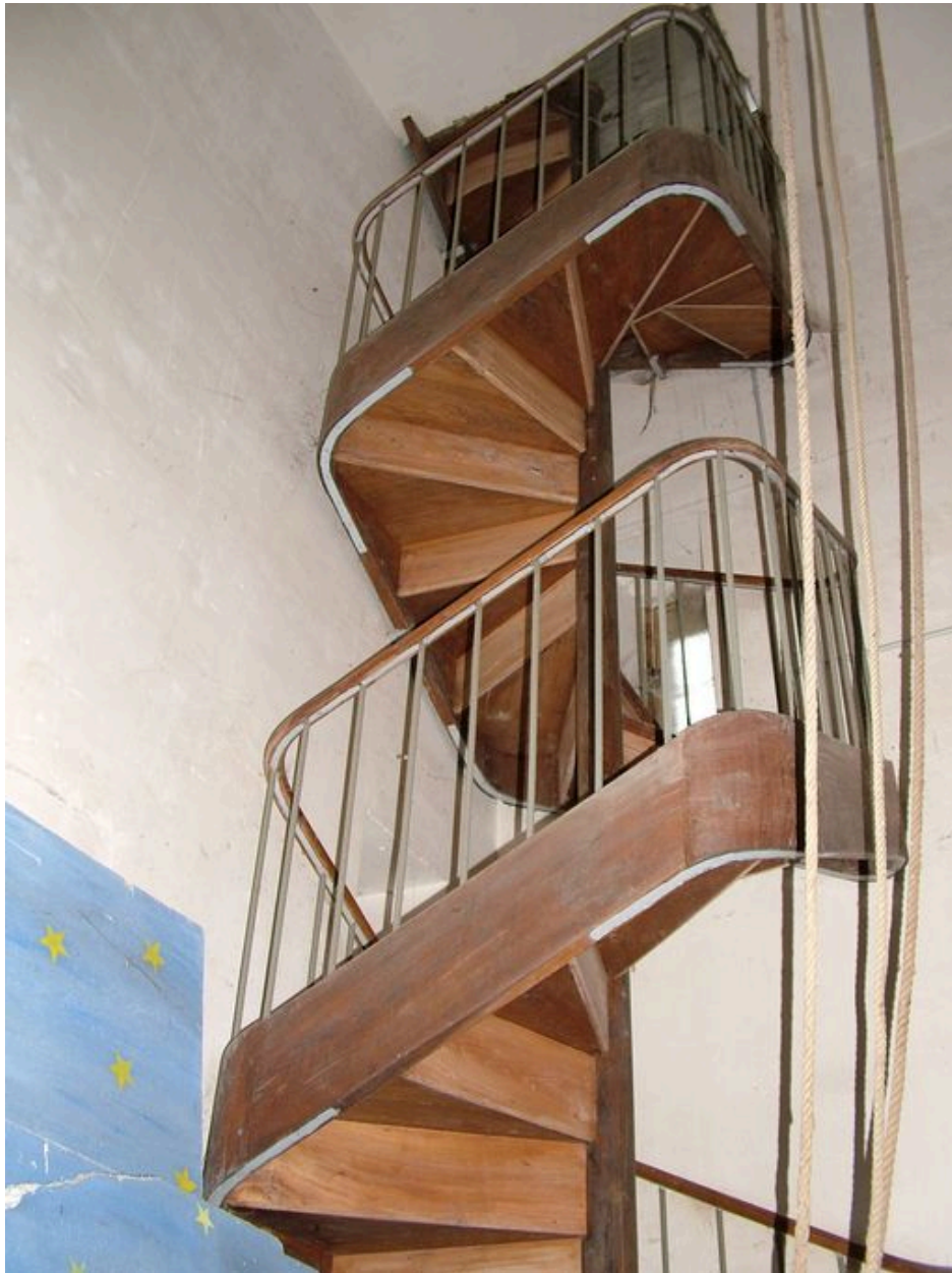
Vue de l'escalier du clocher.
