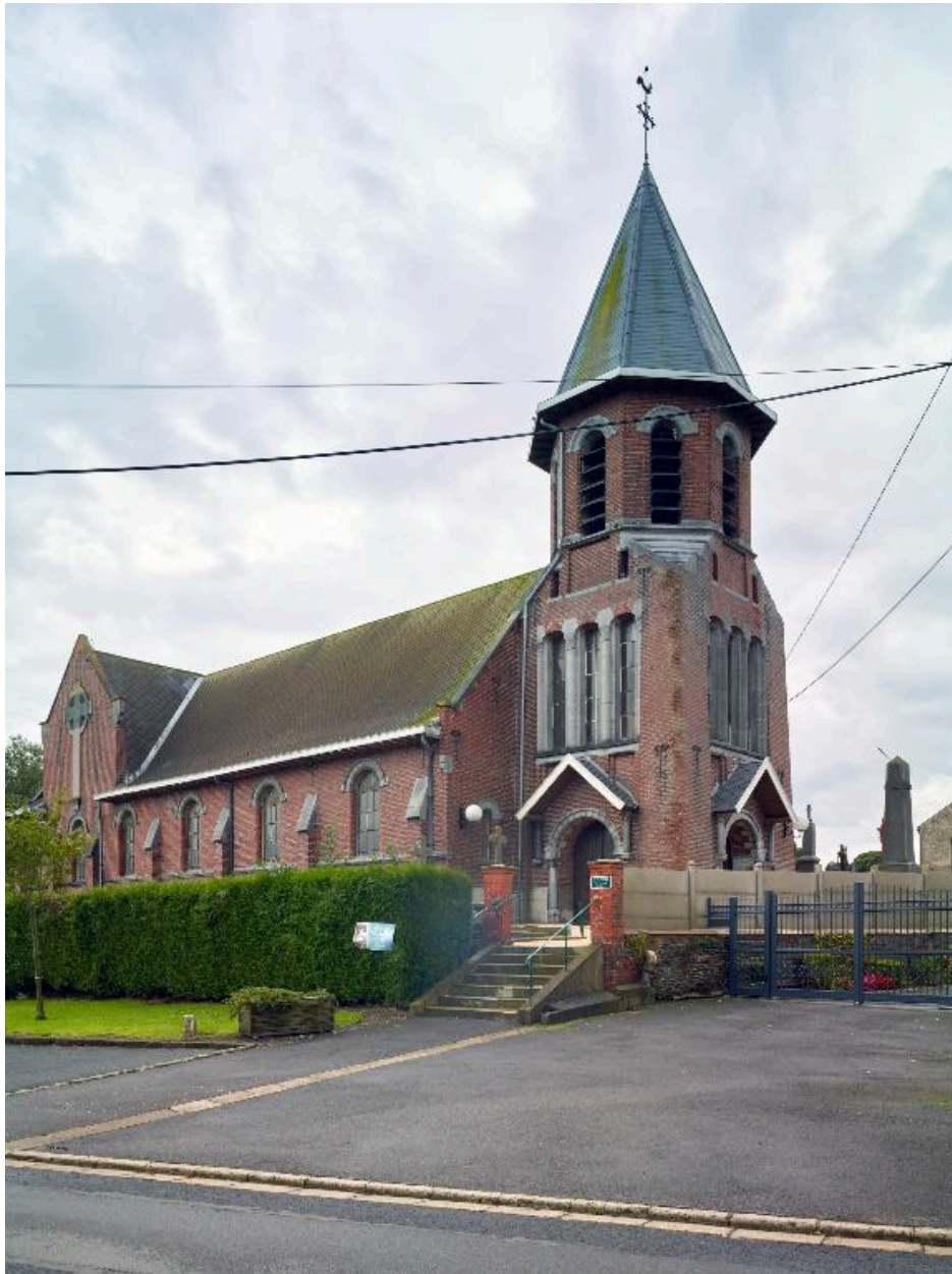
Vue générale de trois quarts, élévation nord.
