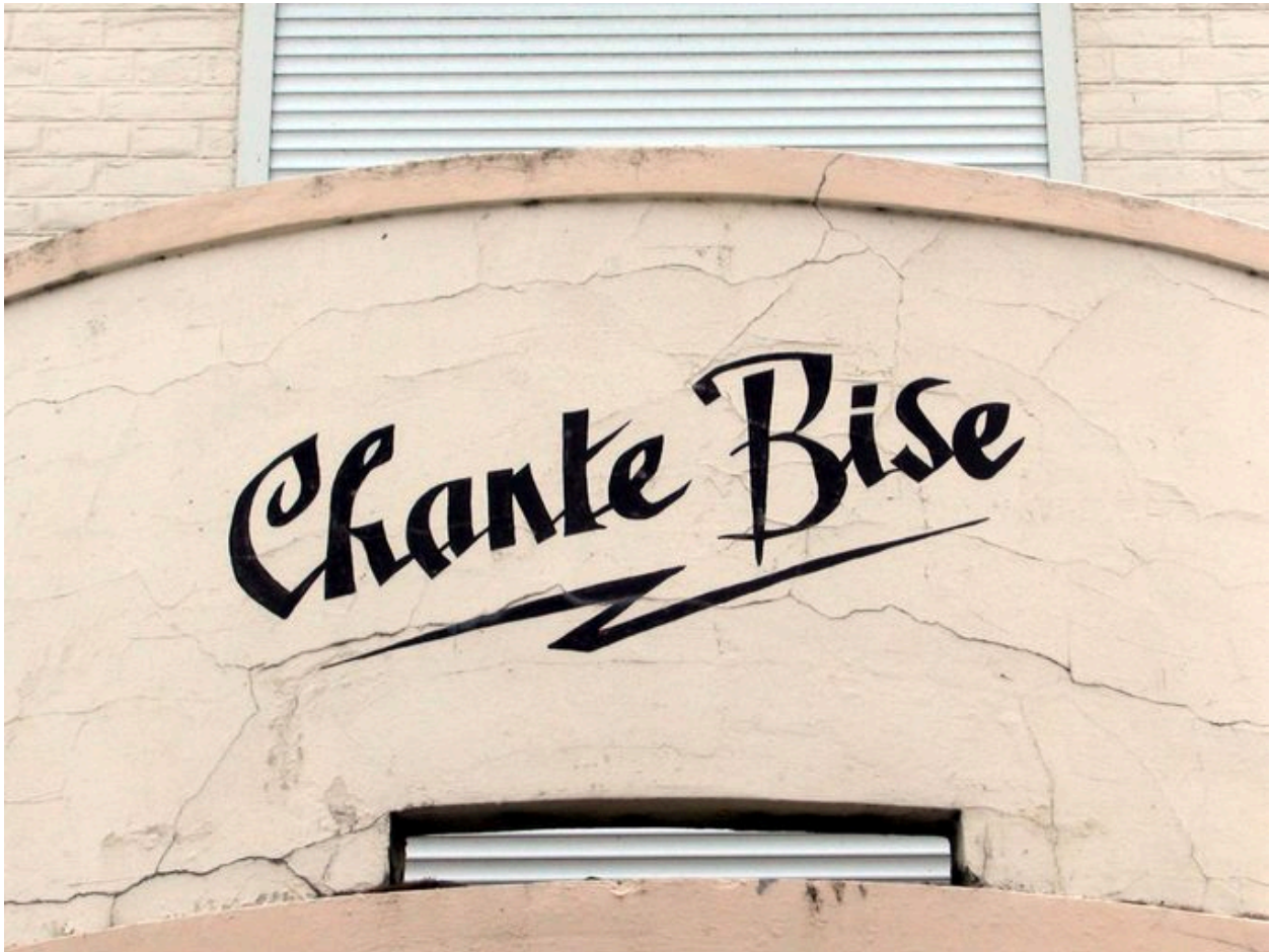
Détail de l'appellation peinte sur un des balcons.
