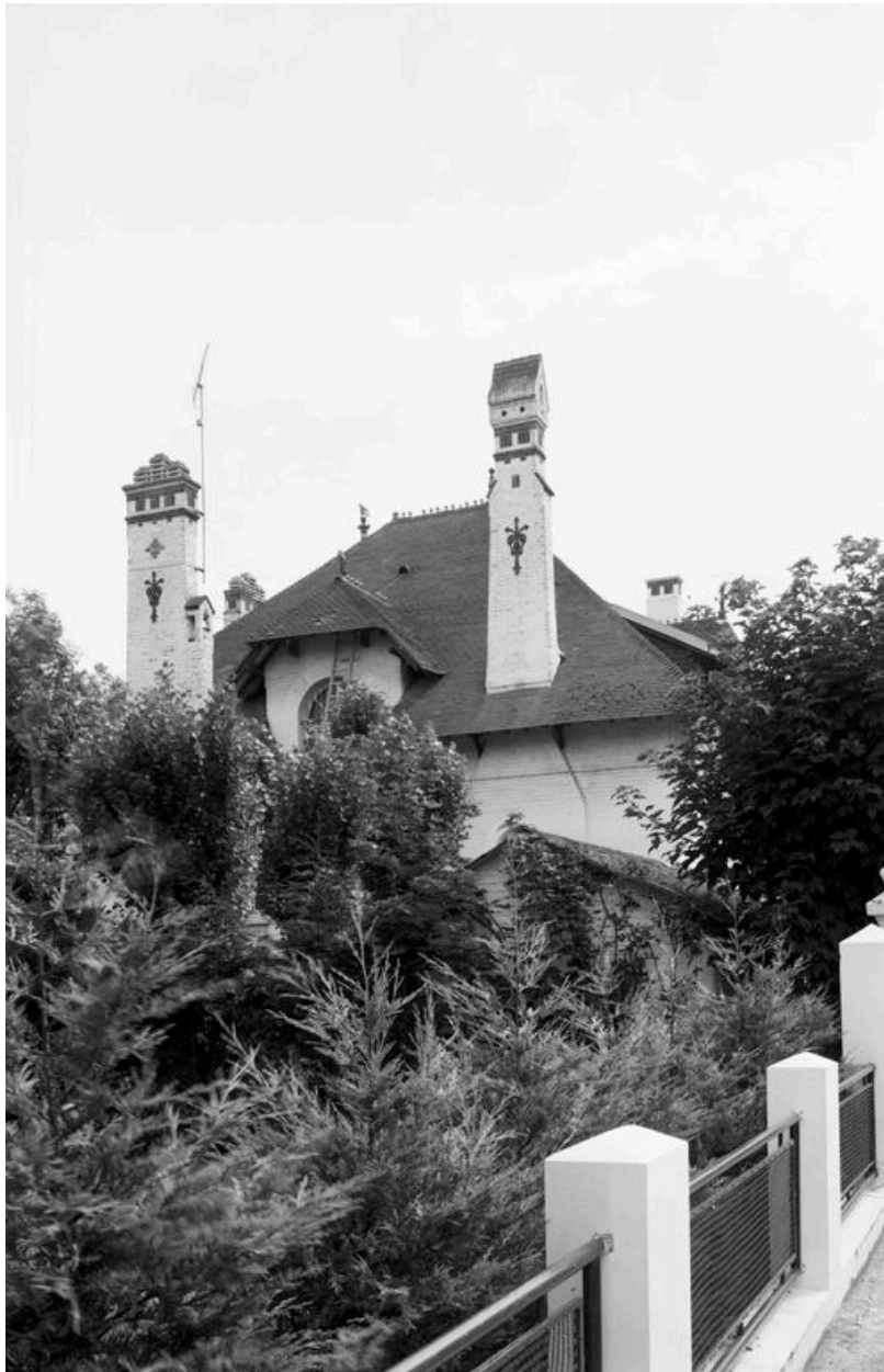
Vue générale postérieure, en 1981.
