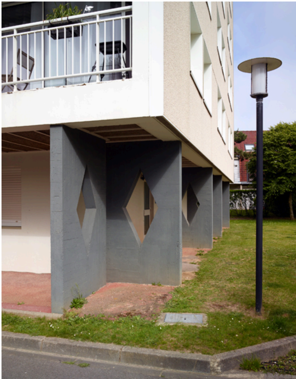
Vue d'une rangée de poteaux de la façade sud des logements de fonction.
