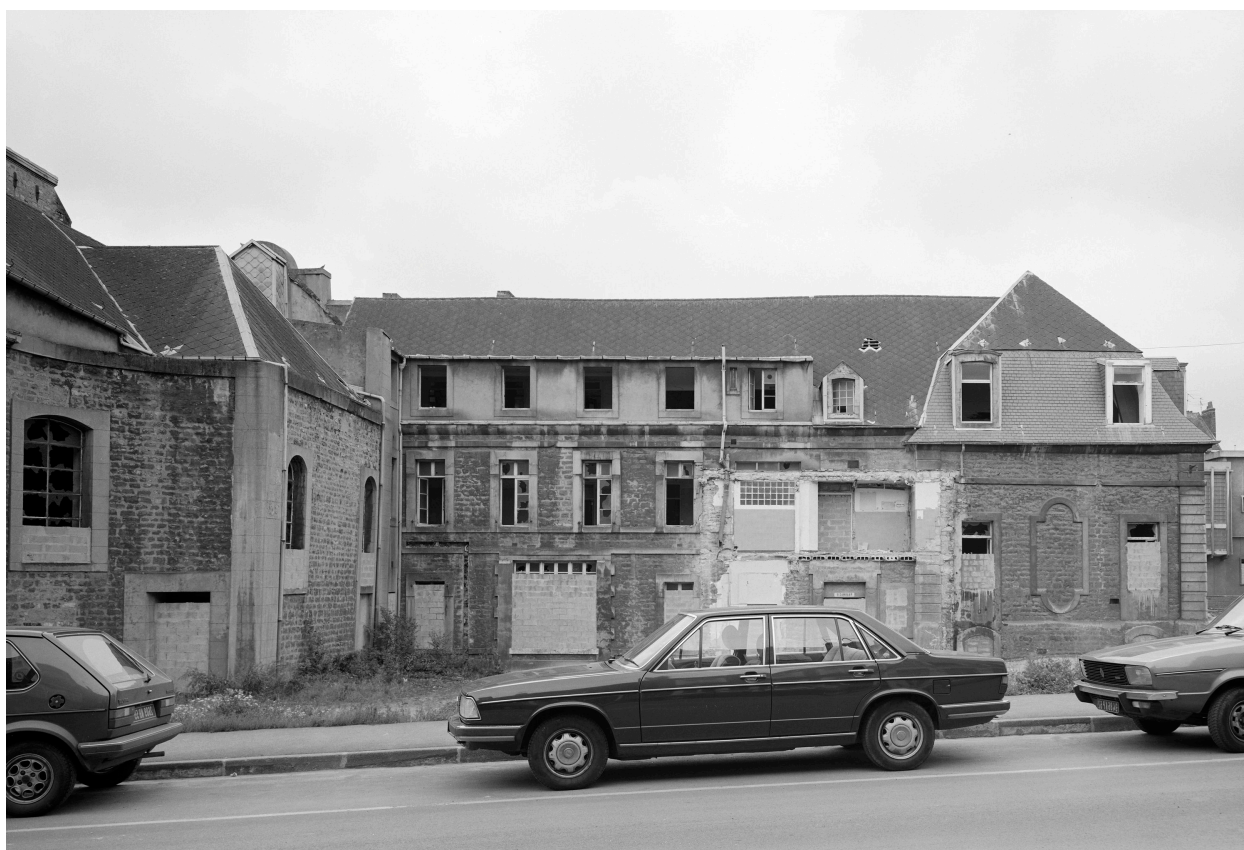
Bâtiment C, partie est, façade partielle rue du Vivier.
