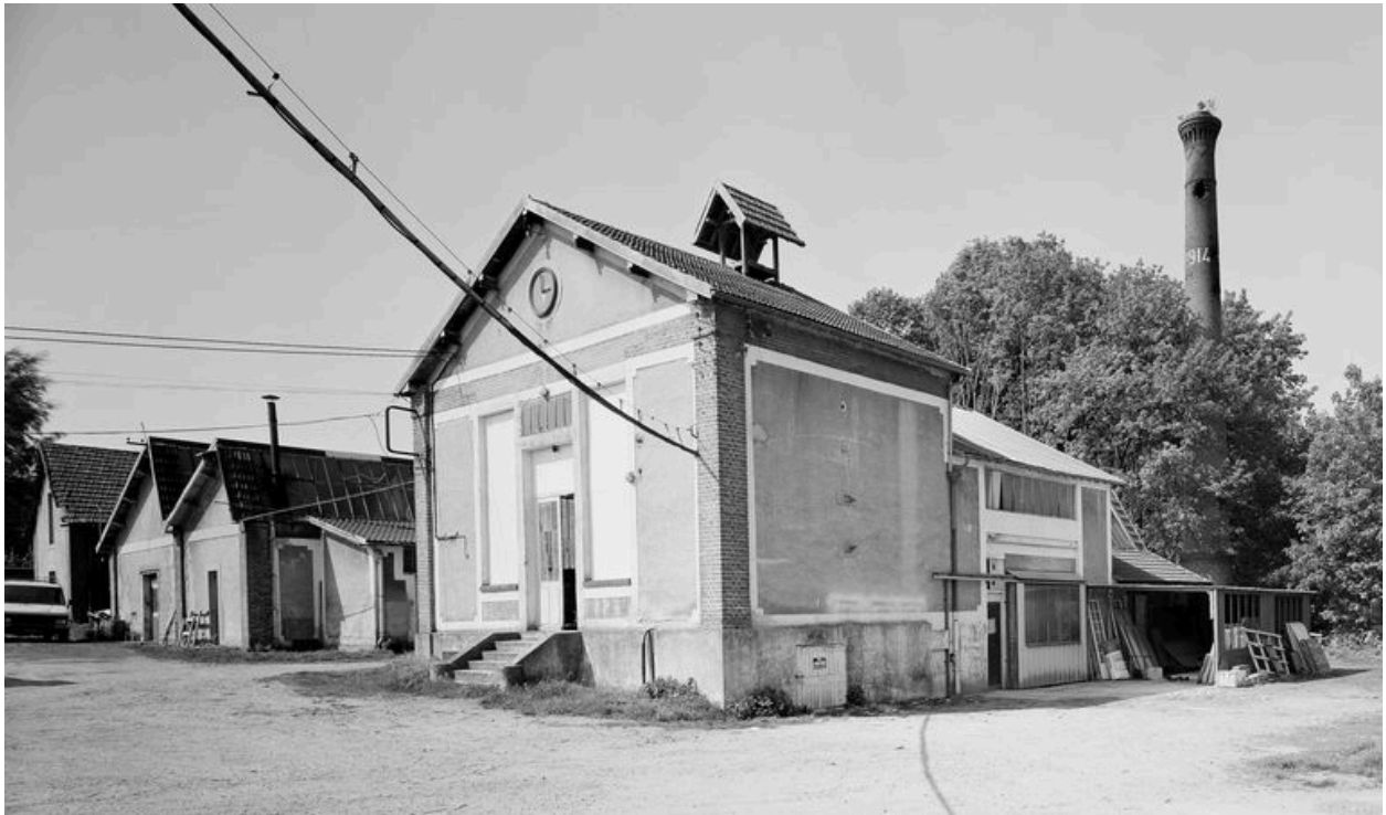
Chaufferie : élévation antérieure.
