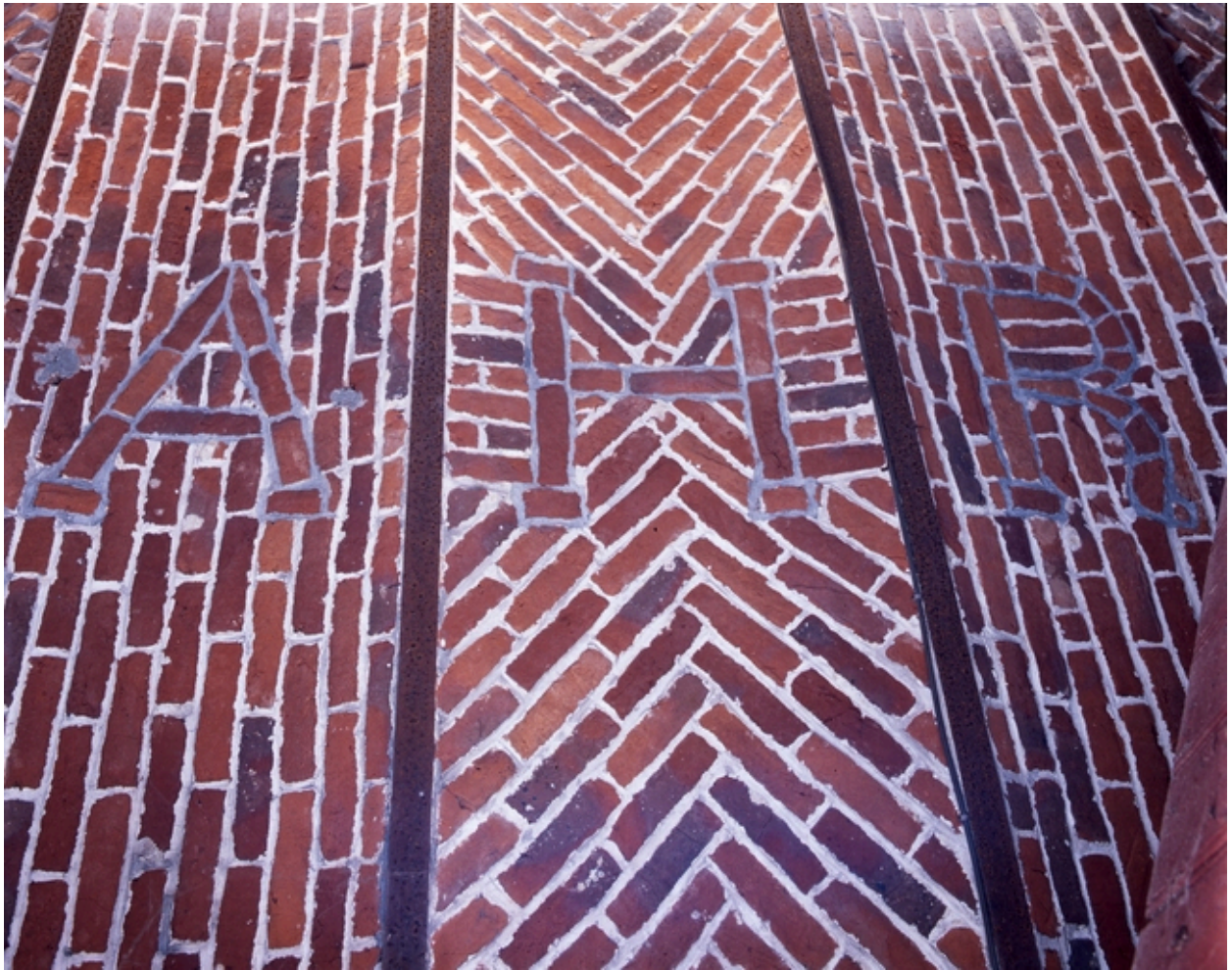
Les voûtes des écuries.
