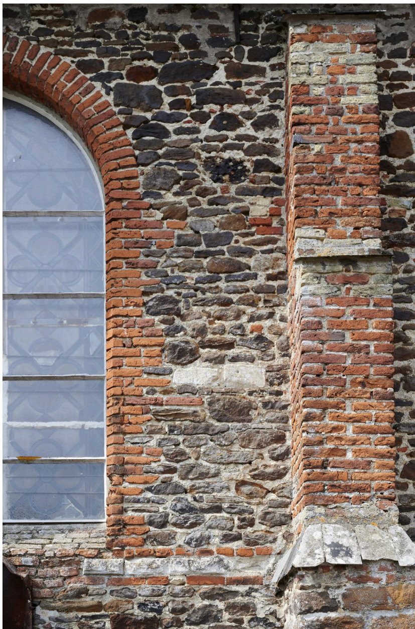
Détail d'un contrefort du bas-côté sud. Baie.
