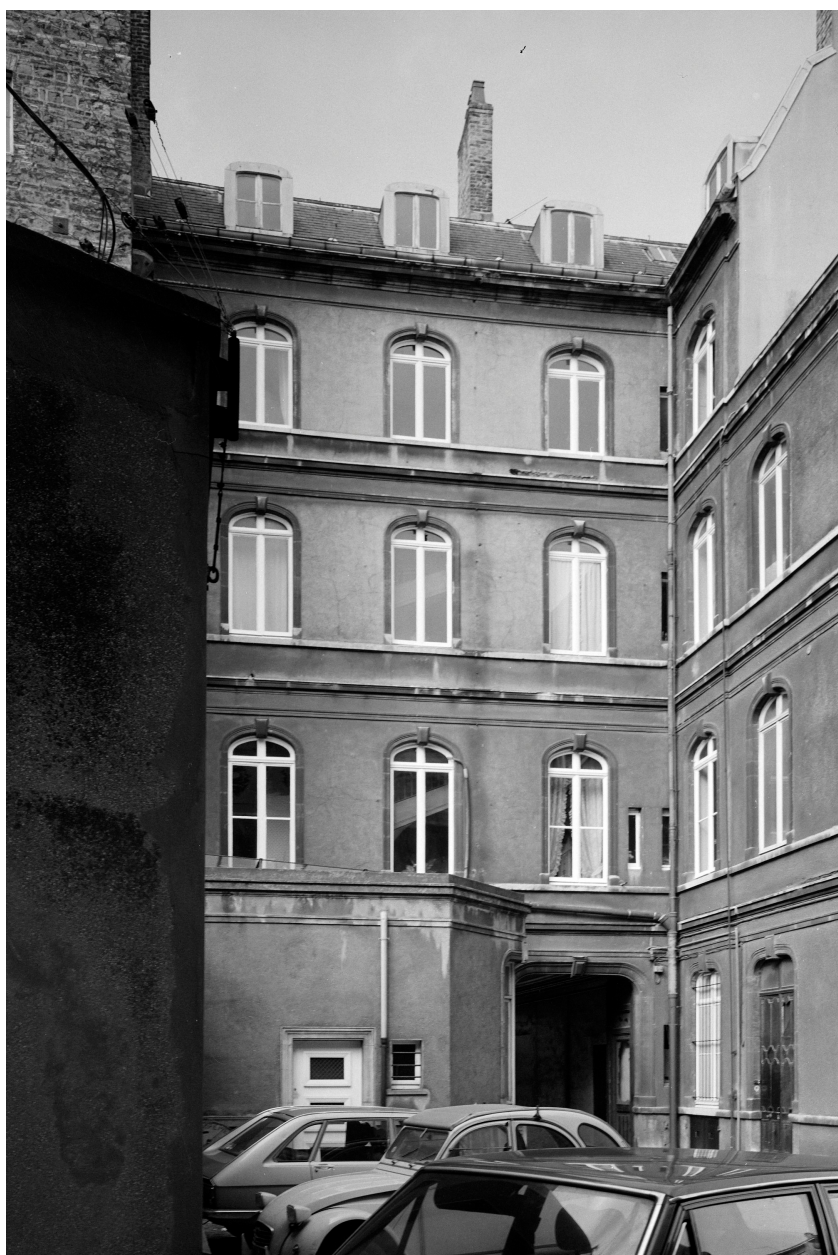
Façade sur cour, vue d'angle.
