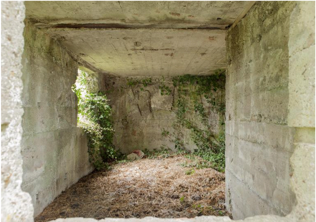
Casemate a), seconde salle en enfilade
