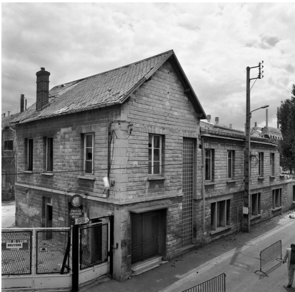
Les bureaux depuis le pont Y, en 1999.
