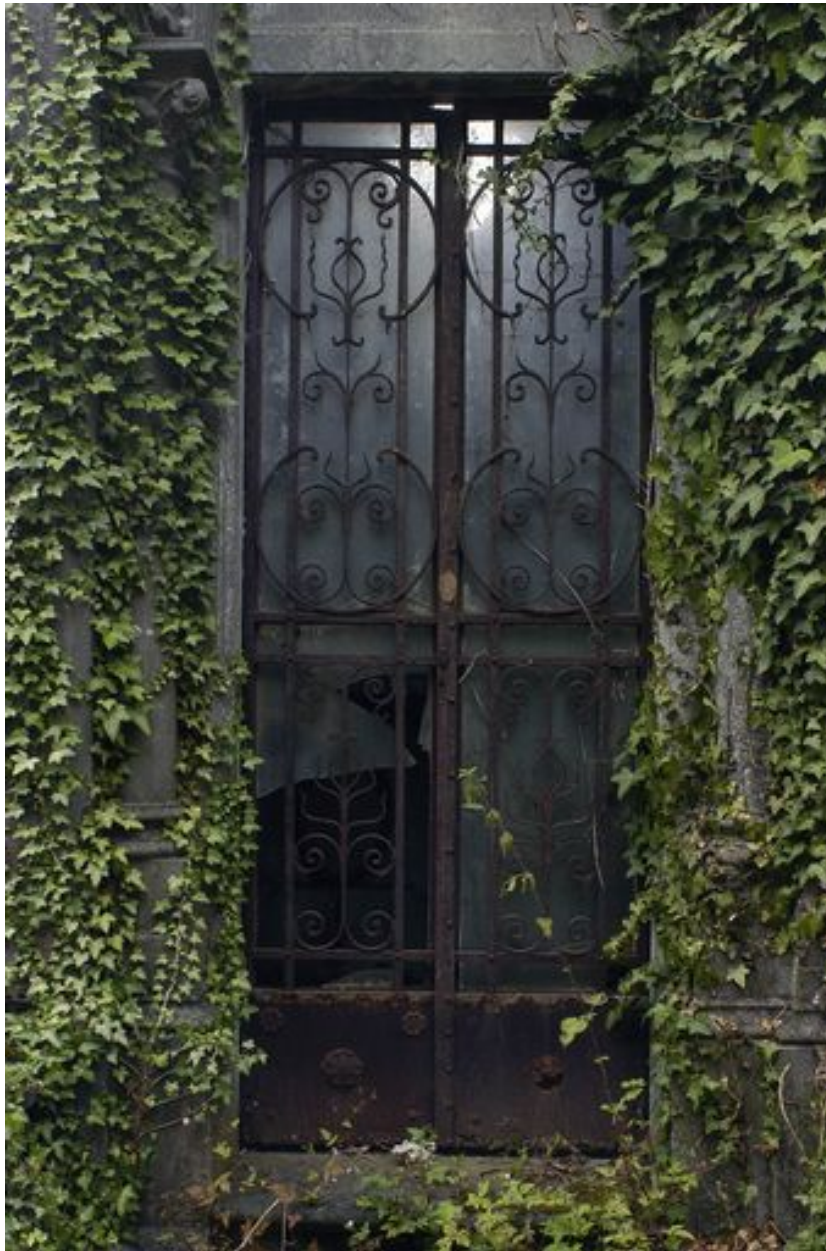
Détail de la porte de la chapelle.
