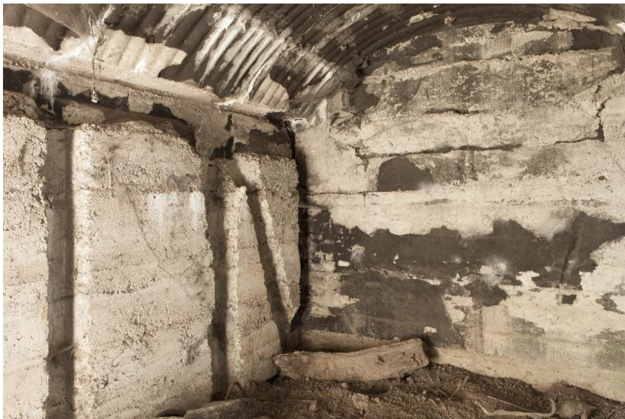
Bâtiment 1, vue intérieure
