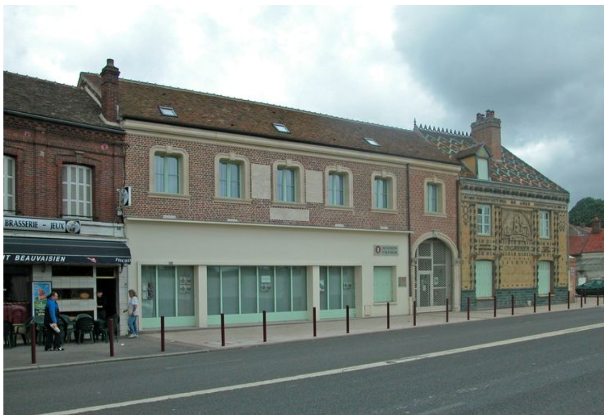
Vue d'ensemble sur rue.
