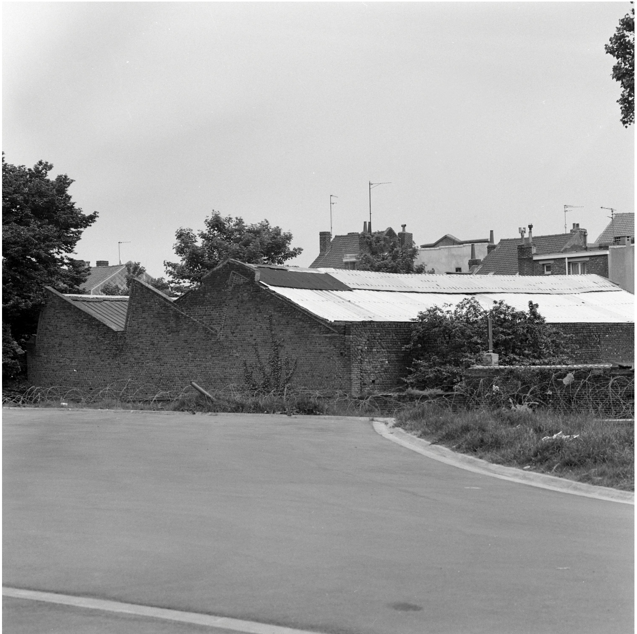
Atelier de fabrication. Vue prise vers le sud.
