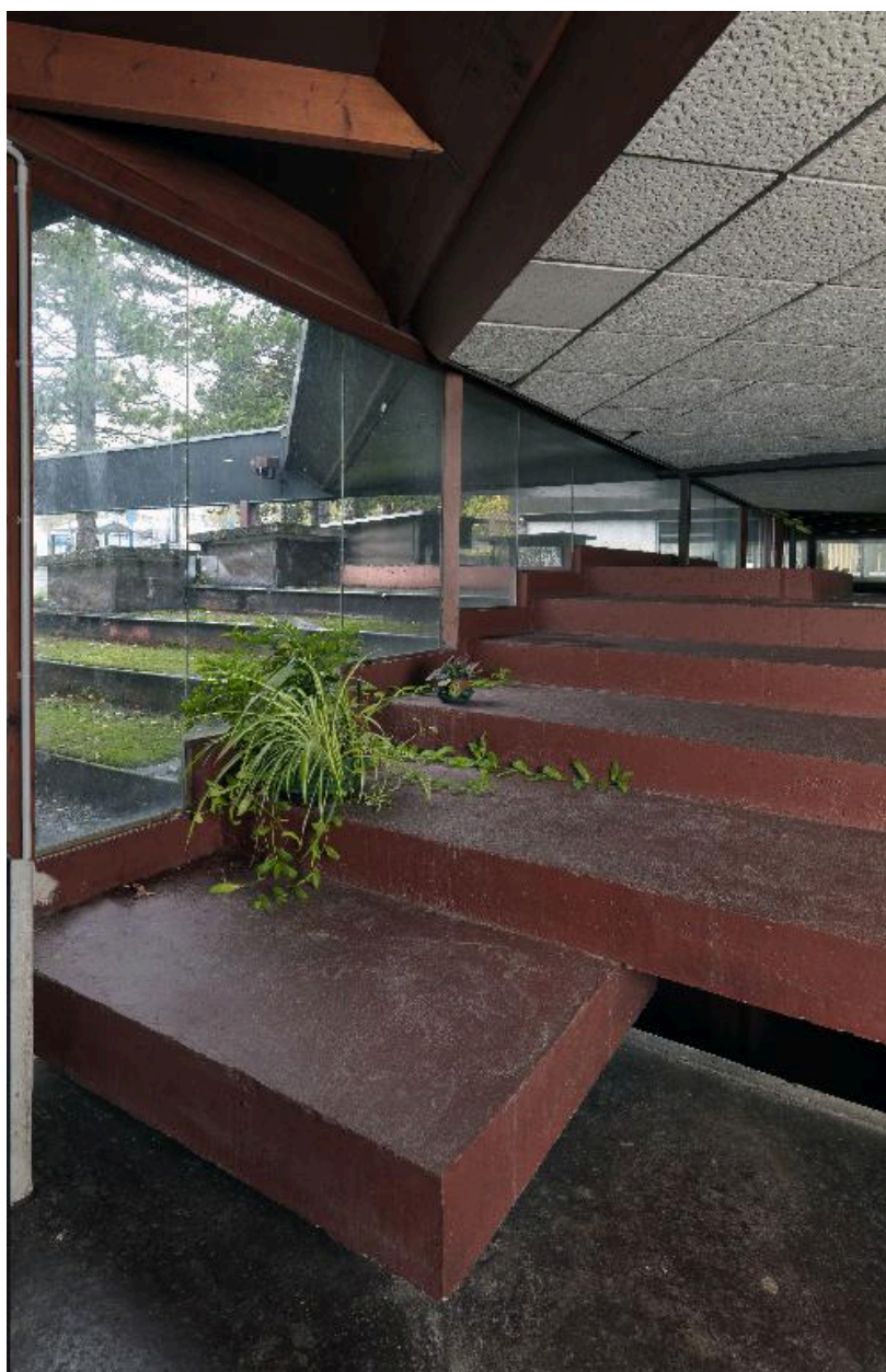
Vue de la dalle de couverture à gradins, au nord.
