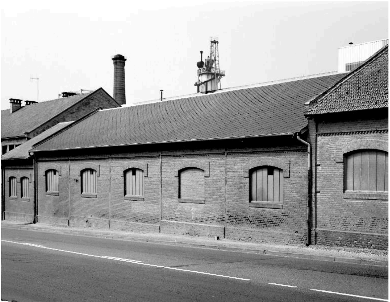
Vue de la façade est d'un atelier.
