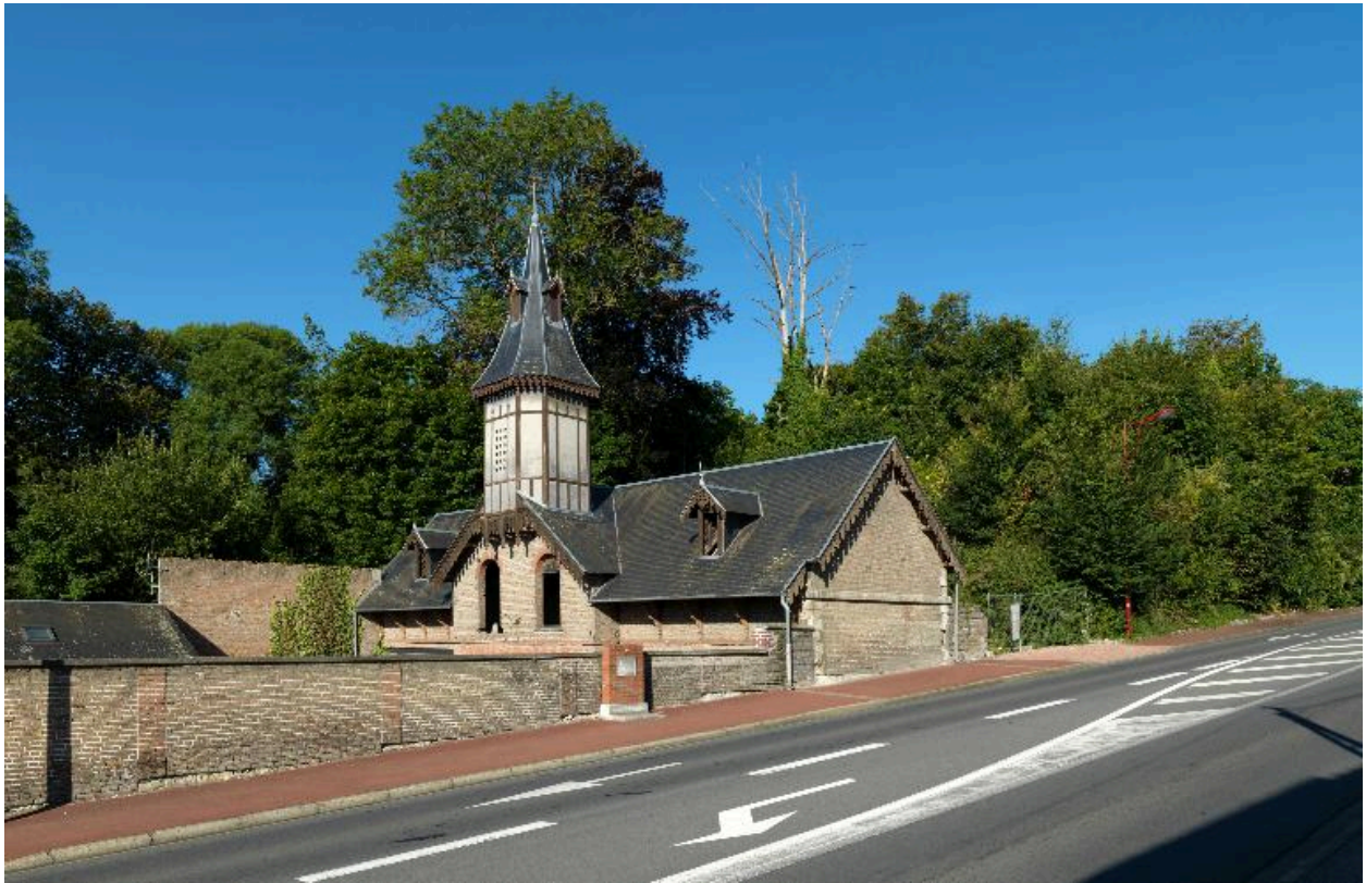
Pigeonnier de la basse-cour du château depuis la rue.
