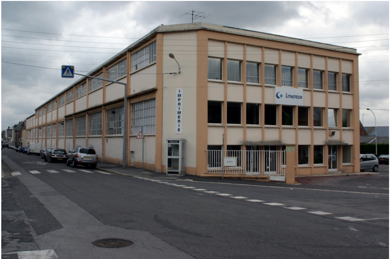
Façades des ateliers rue Quentin-Barré, et des bureaux construits en 1964.
