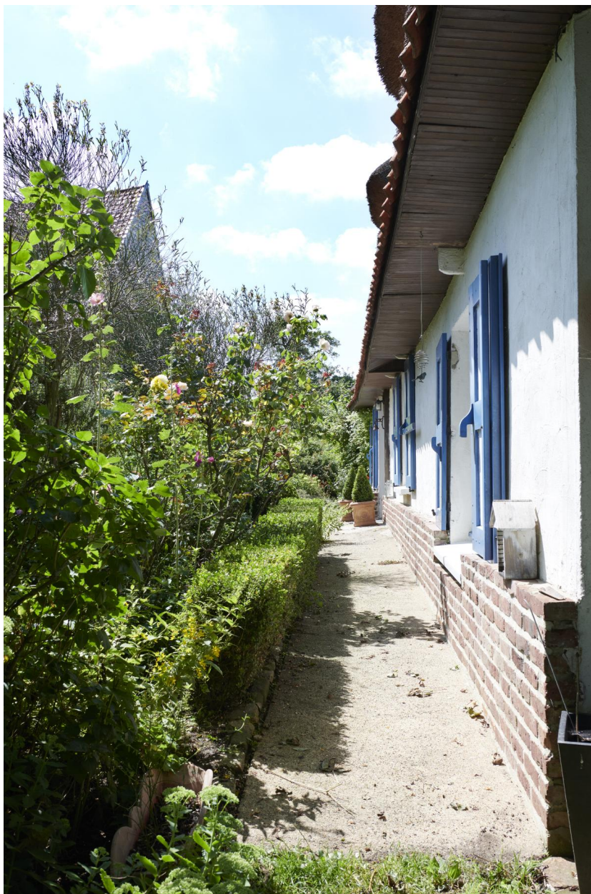
Bordure de la façade sud-est.
