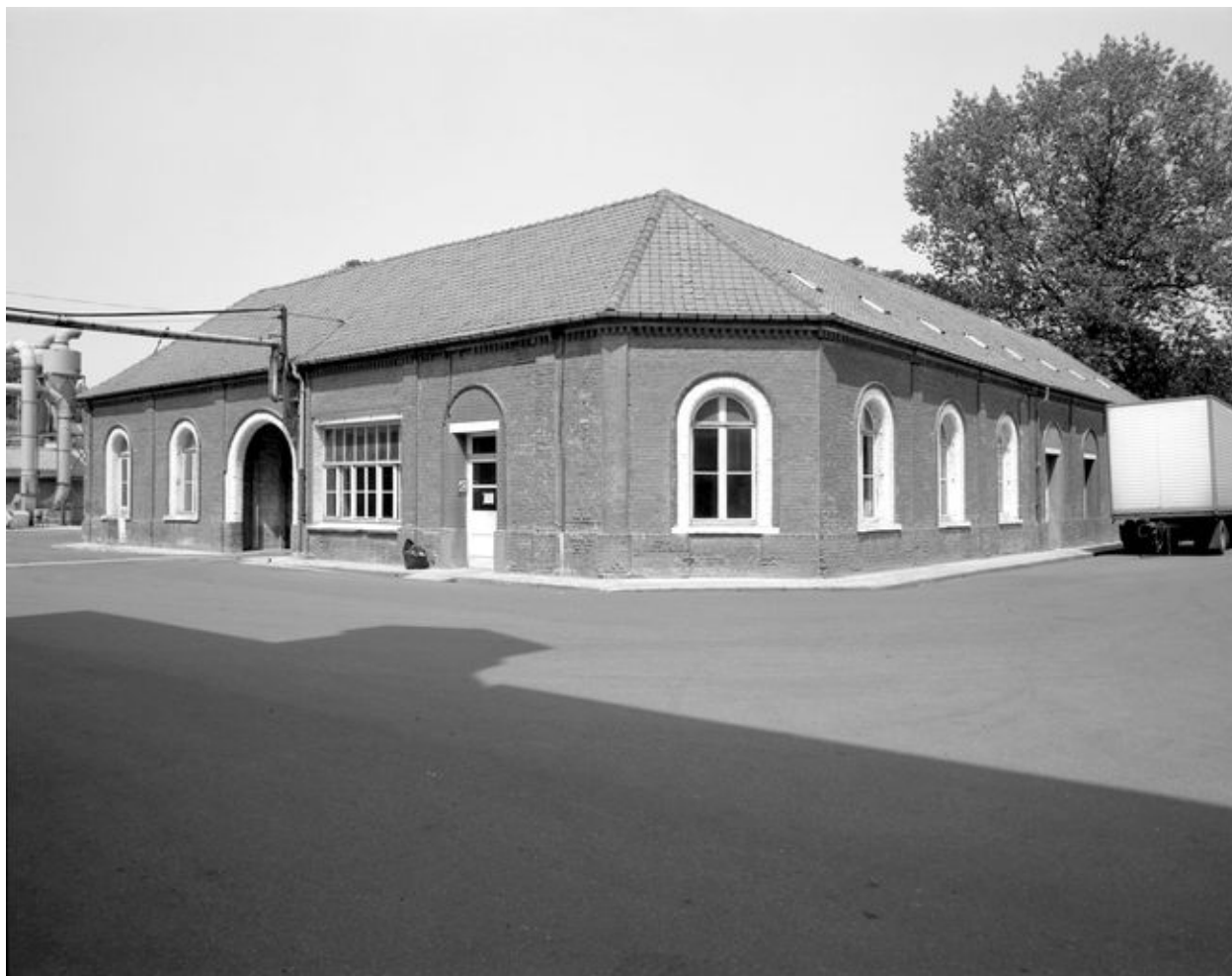
Edifice industriel (depôt divers, anciennement bureau), en 1989 : élévation sud-est.
