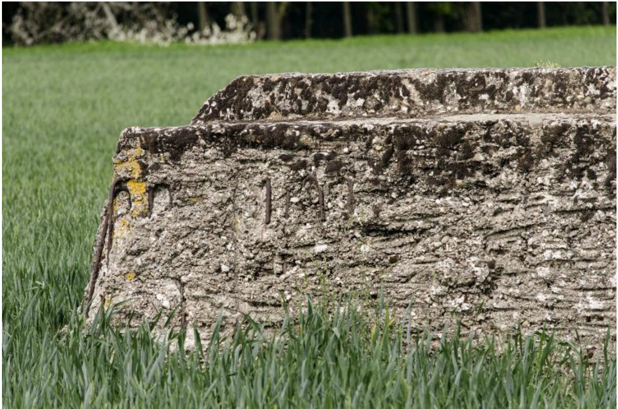
Détail du ferrailage sur l'élévation sud-est.
