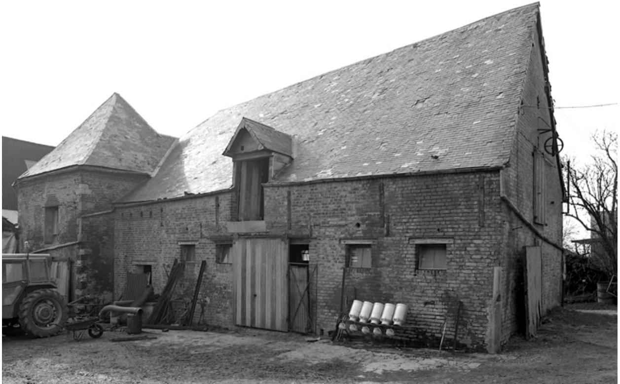
Etable, à l'ouest de la cour.
