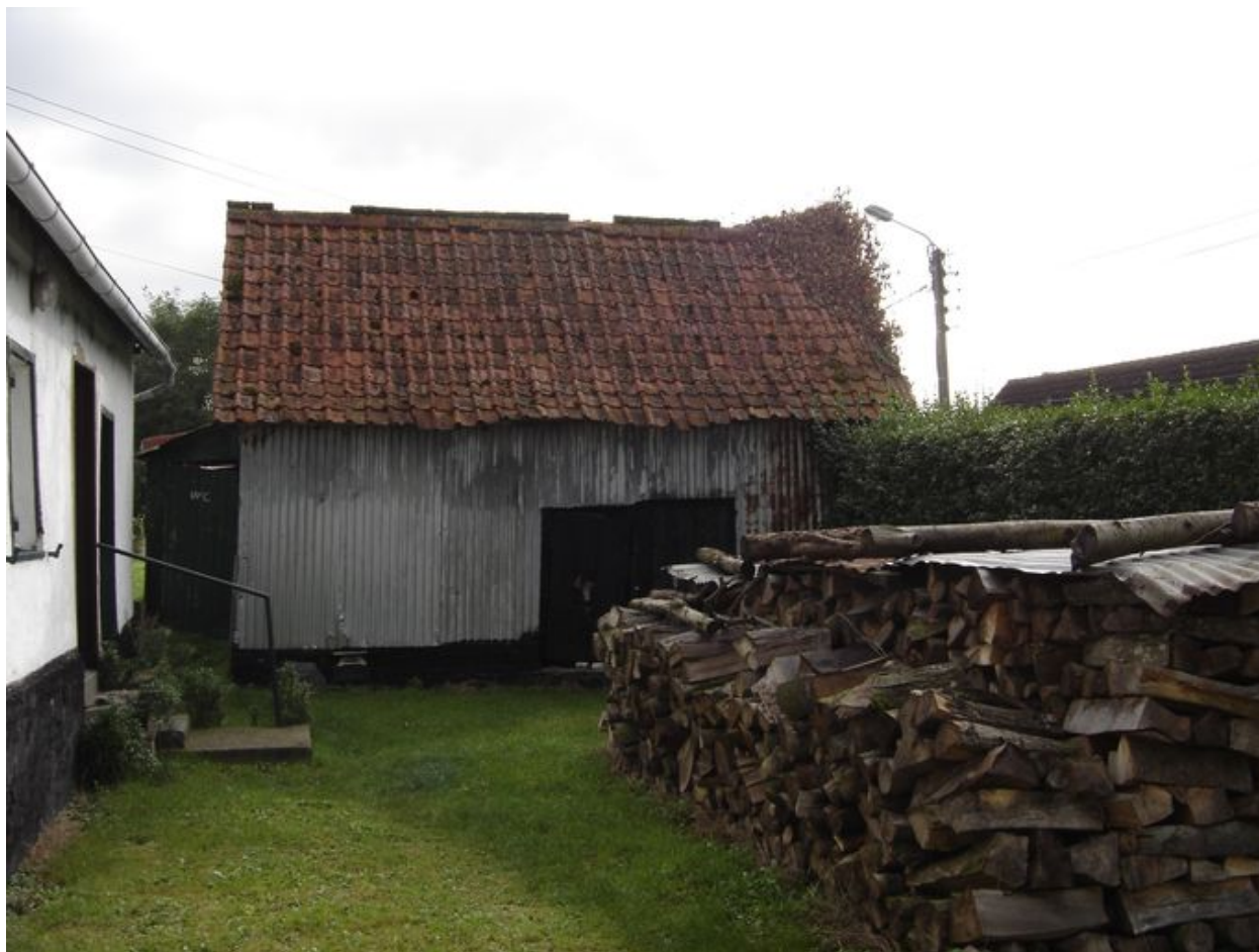
Vue de la grange.
