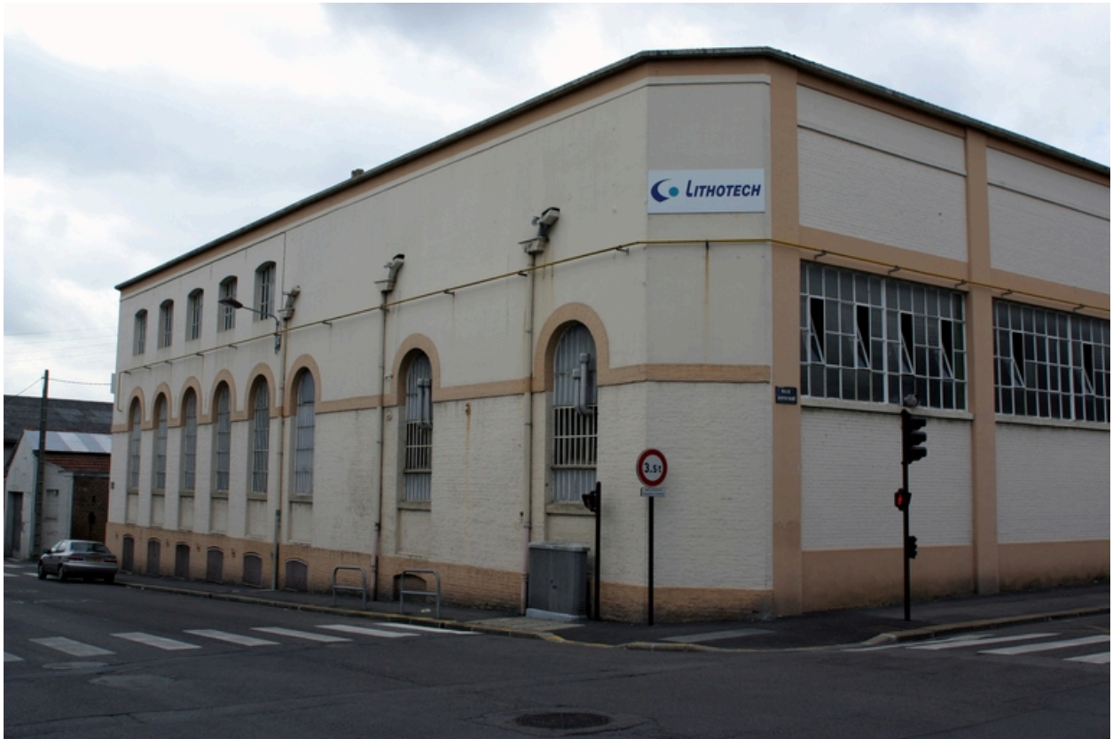
Façade des ateliers, à l'angle des rues de Mulhouse et Quentin-Barré.
