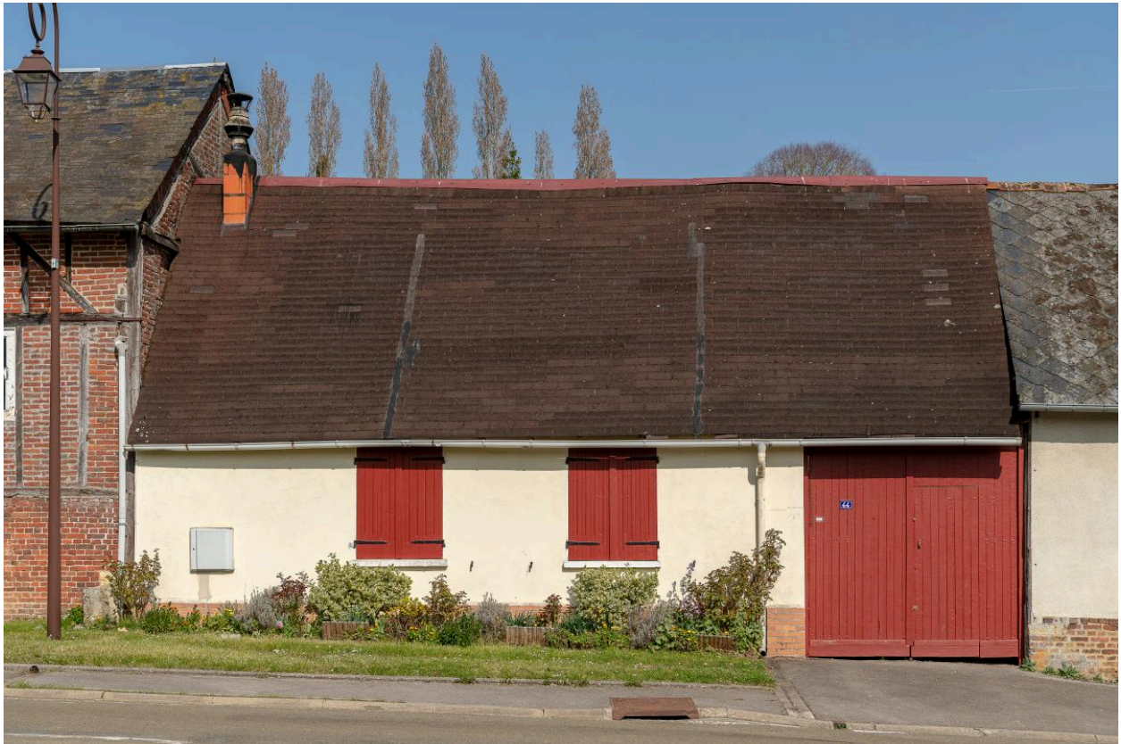
Logis avec entrée charretière sur rue, n°44 Rue Principale, vue depuis le sud-ouest.
