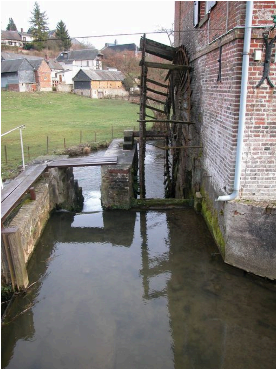
Le canal d'amenée.
