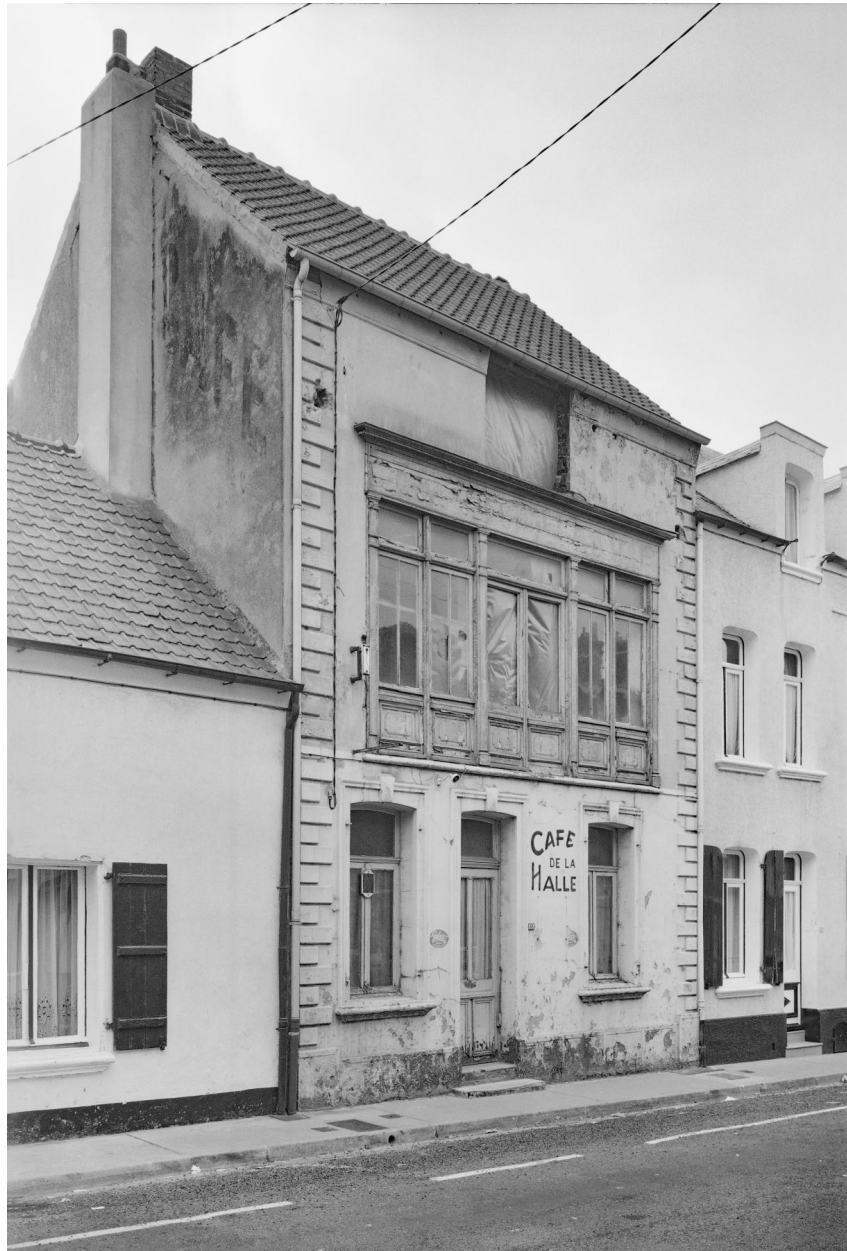
Vue générale du commerce depuis la rue.
