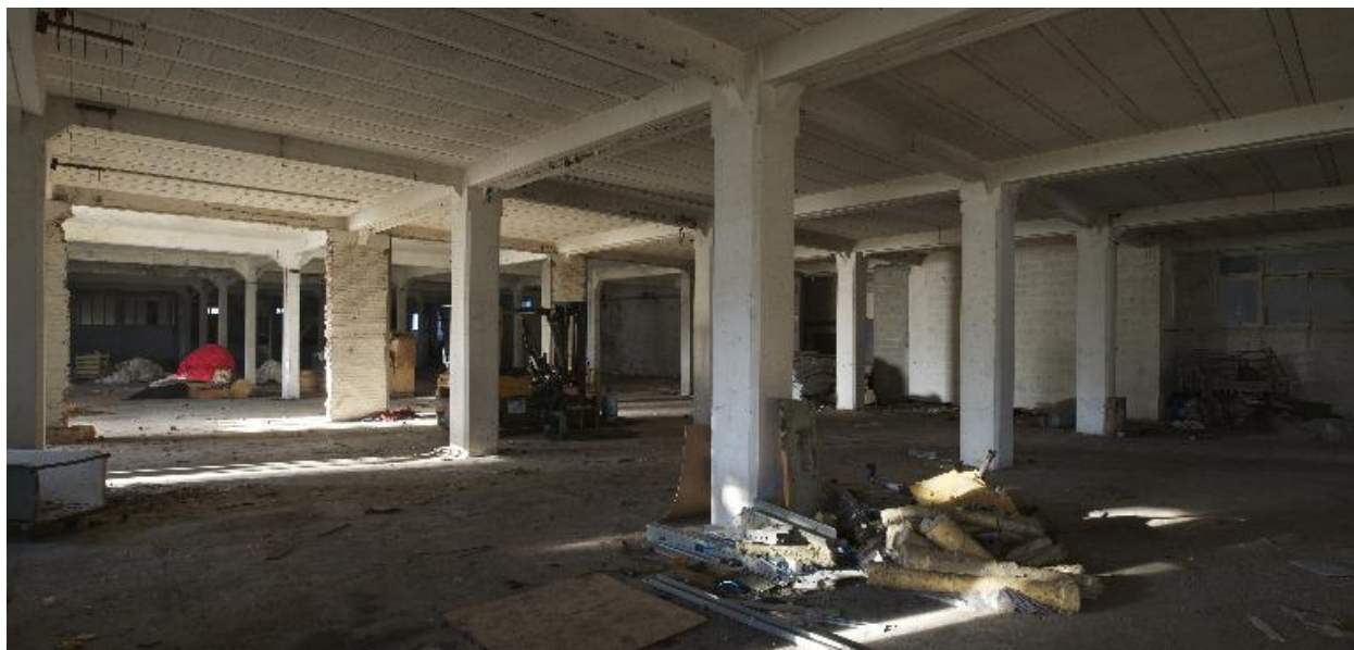
Intérieur de l'entrepôt aux matières premières.
