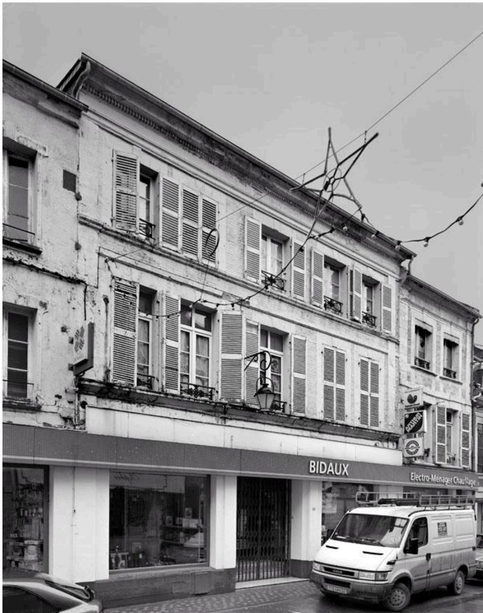
Vue de la façade sur rue.
