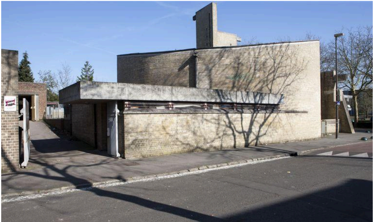
Vue du flanc ouest et sud.
