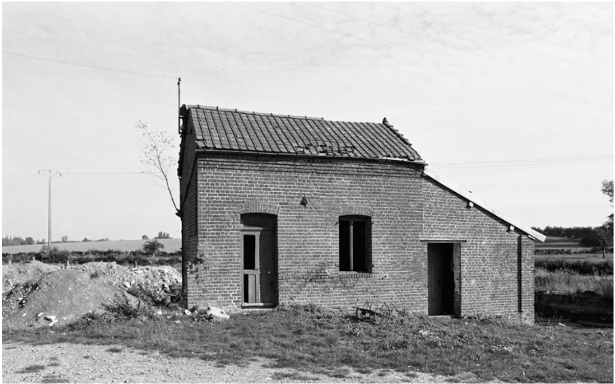
Deuxième ferme : façade d'un logement d'ouvrier agricole.
