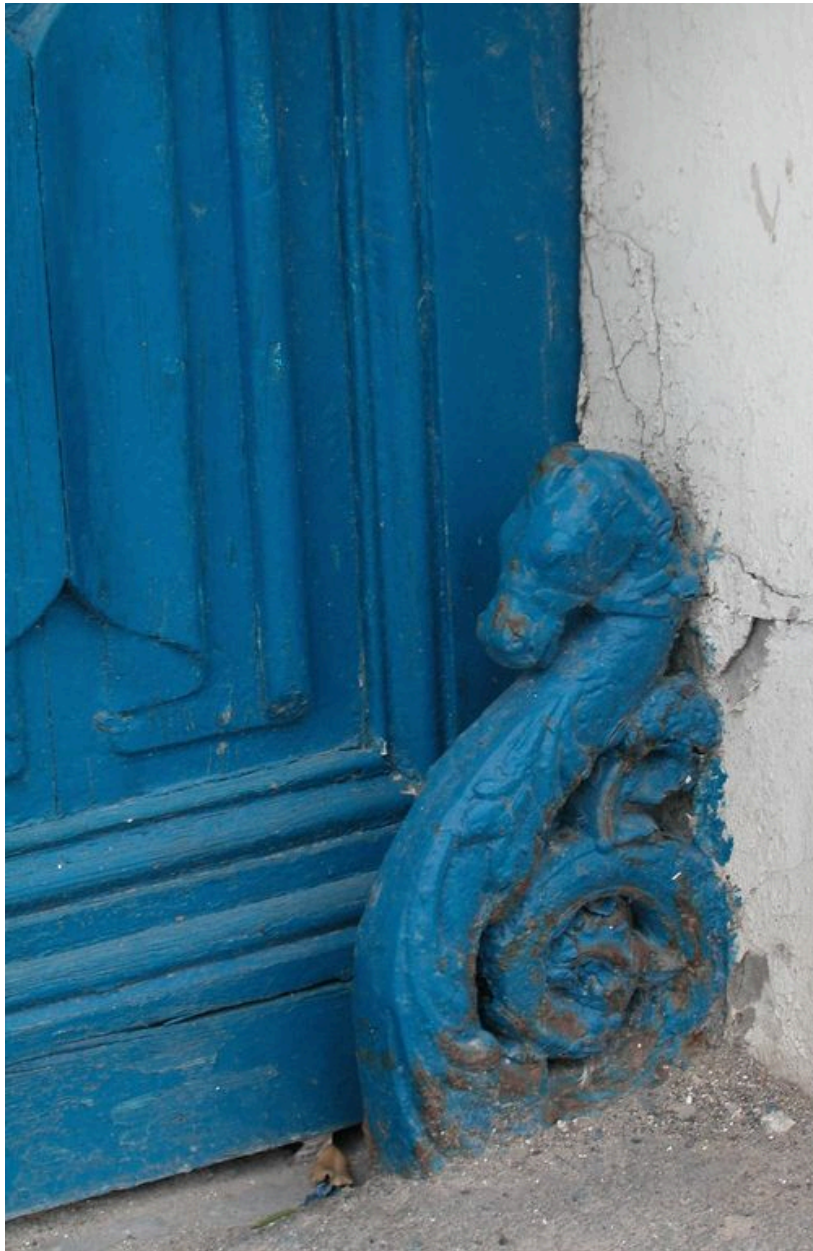
Détail du chasse-roue d'une des portes cochères.
