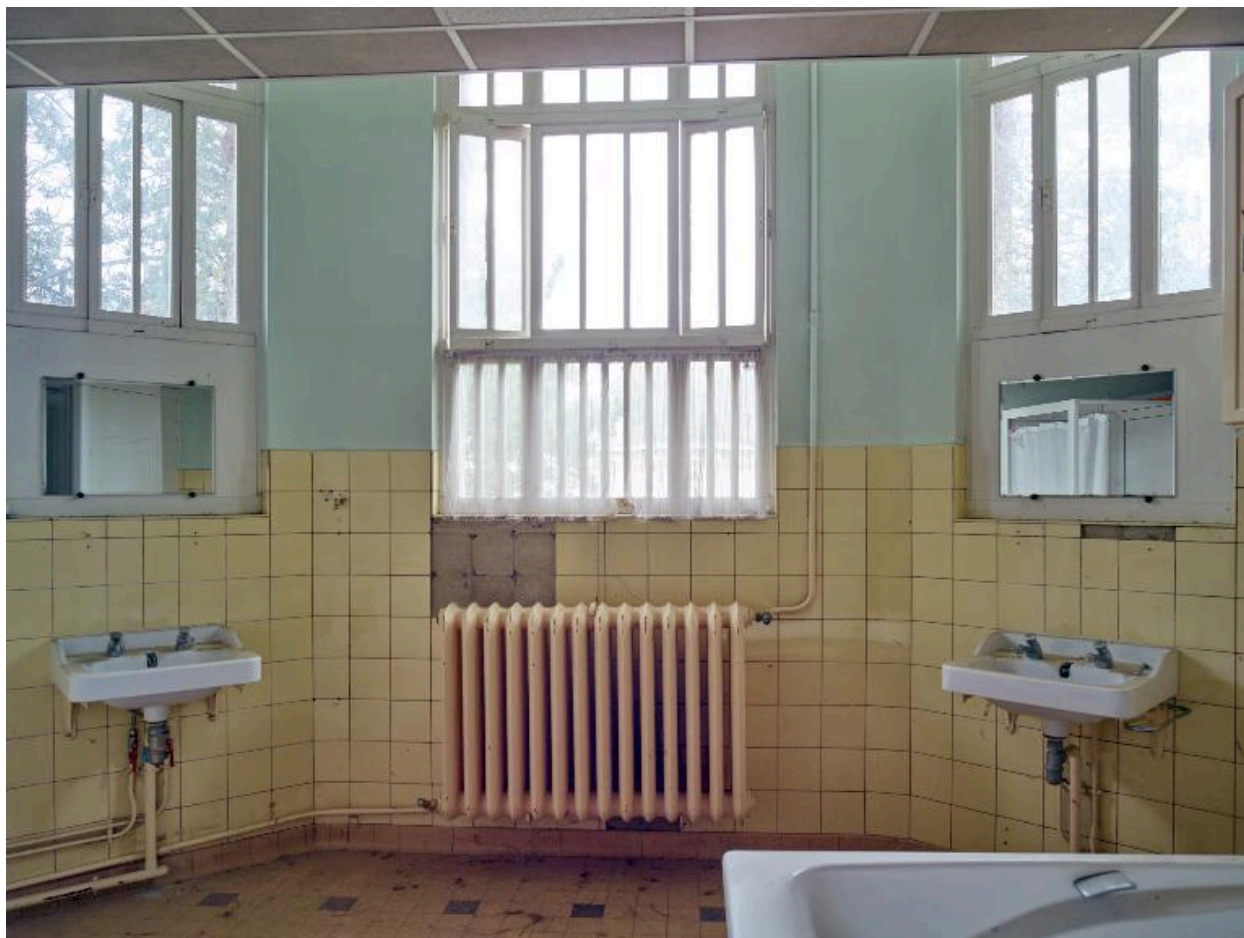
Bâtiment d'hospitalisation du pensionnat dit pavillon P3, 1er étage, salle de bains, détail de la paroi intérieure au revers de la façade, vue axiale.
